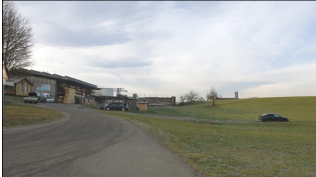
Abbildung 5: Zufahrtsstraße in das bestehende Gewerbegebiet, mit abknickendem, asphaltiertem Weg (Ostgrenze).
