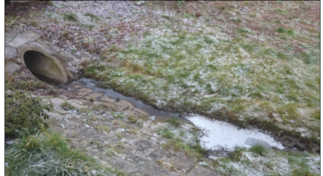
Abbildung 6: Retentionsgraben im Geltungsbereich. Austritt an der Südwestgrenze. Von dort westlicher Verlauf durch das Plangebiet.
